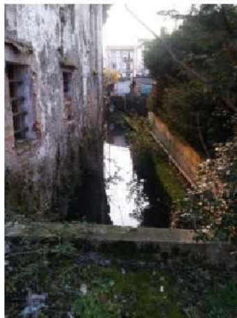
Particolare canale su fronte nord del mn. 83
