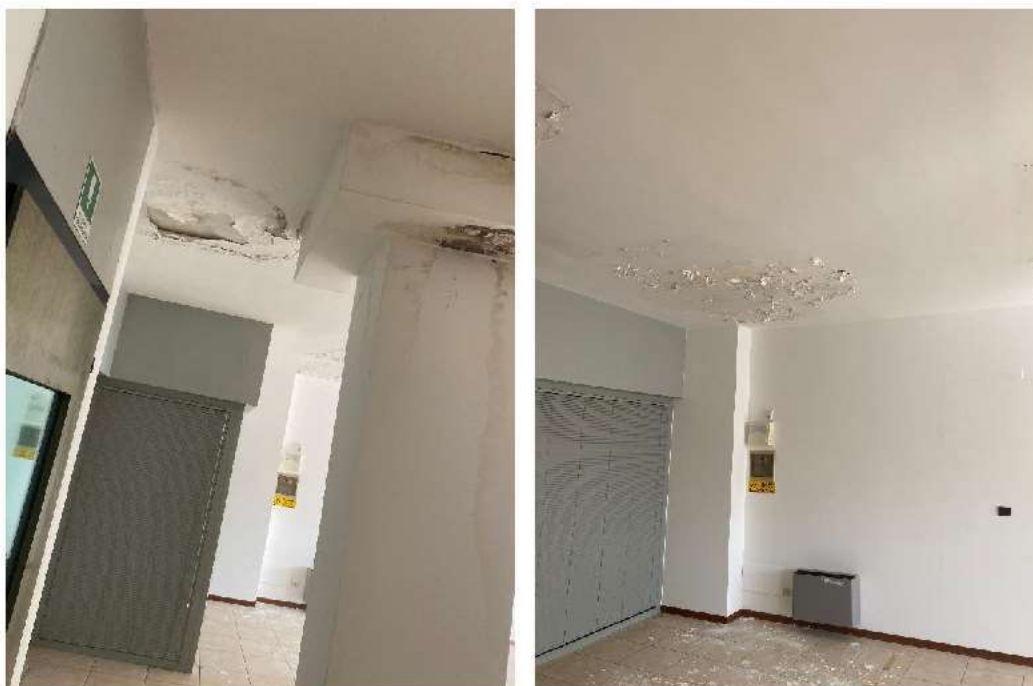
Unità commerciale sub. 134
